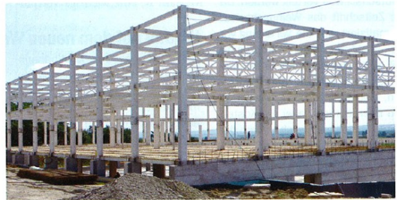
Im Bau: Die Stahlkonstruktion des Zentrums steht bereits.
